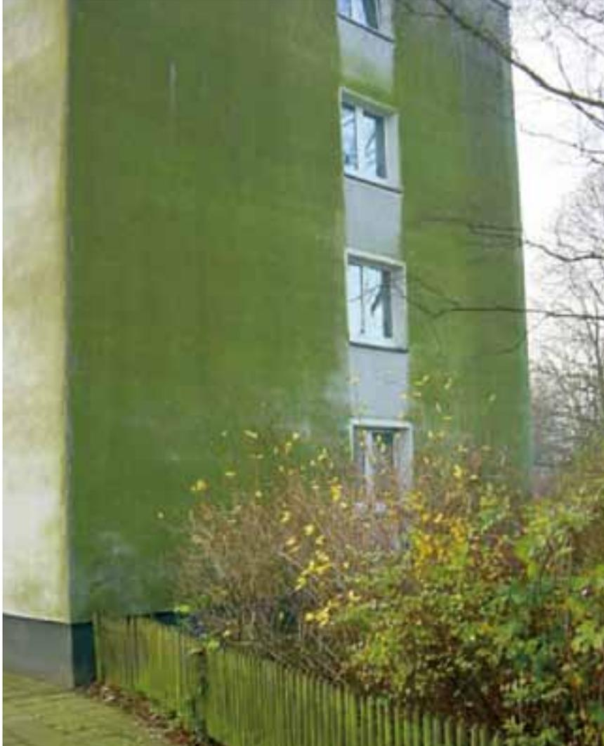
Le superfici colonizzate vanno esaminate accuratamente. Se accanto alla presenza di microrganismi si riscontrano anche carenze progettuali o di esecuzione, queste ultime vanno se possibile ovviate prima di iniziare il risanamento, ossia il trattamento delle superfici interessate.
